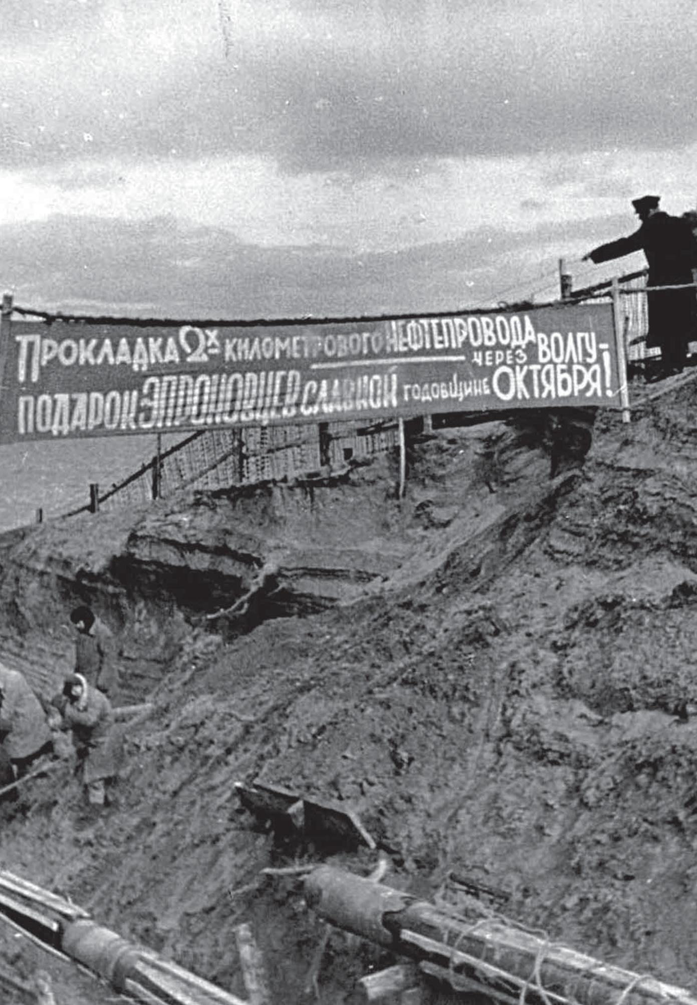
Прокладка нефтепровода Зольное - Кряж через Волгу. 1947 год
