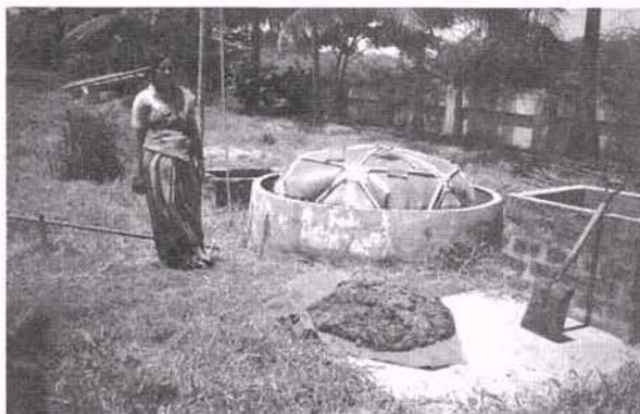
Рис. 12.23. Устройство для получения биогаза в Индии. Навоз животных помещают в чан, где он разлагается и выделяет газ метан.
