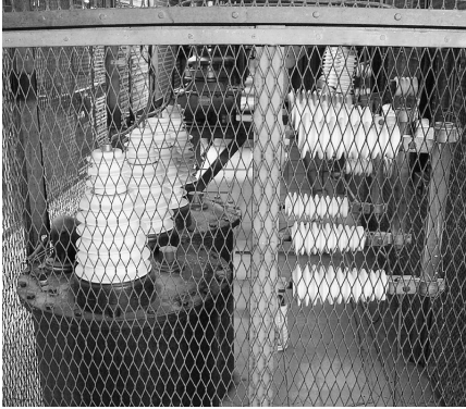
Рис. 16.5. Использование клетки Фарадея на электростанции (фото из Википедии)
