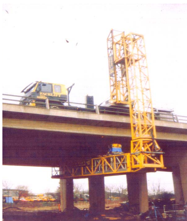
Рис. 86. Контроль деталей моста. Максимальная просвечиваемая толщина бетона 1,5 м
