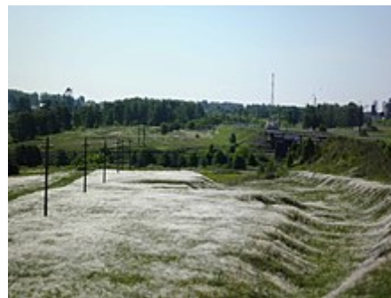
Железнодорожный мост на линии ЮУЖД Чурилово — Каменск-Уральский через реку Течу возле посёлка Муслюмово. Белым на солнце отсвечивают остья ячменя гривастого
