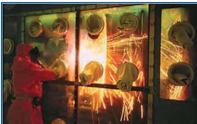
Рис. 1.134. Демонтаж перчаточных отделений в Роки-Флэтс
