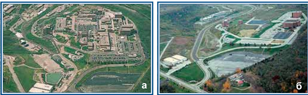
Рис. 1.139. Внешний вид площадки до и после проведения работ по очистке территории комплекса Маунд Сайт
