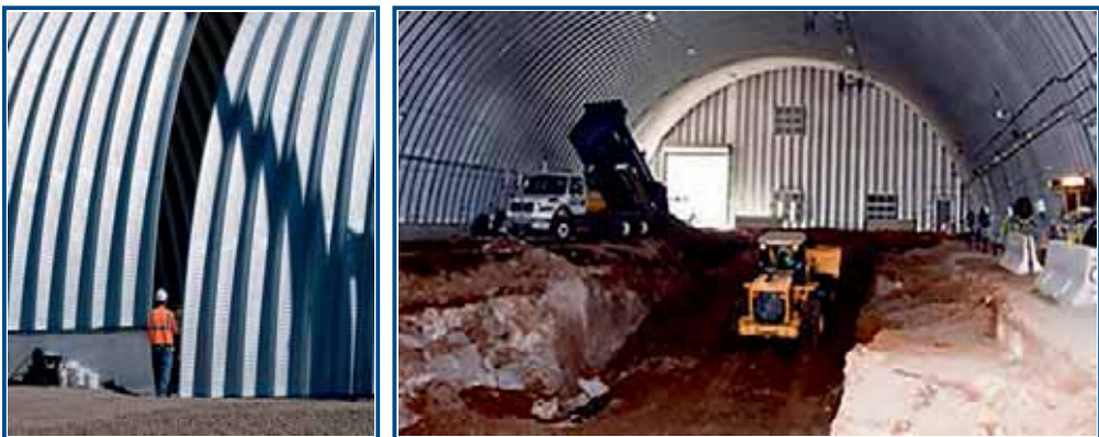
Рис. 1.68. Ангар, сооруженный вокруг полигона В
