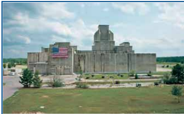
Рис. 1.49. Здание реактора Р, помещенное в «коккон» из бетона
