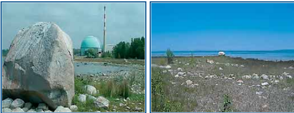
Рис. 1.107. Реактор Big Rock Point, выведенный из эксплуатации по стратегии DECON (слева – состояние площадки до начала проведения работ по выводу из эксплуатации, справа – текущее состояние площадки)
