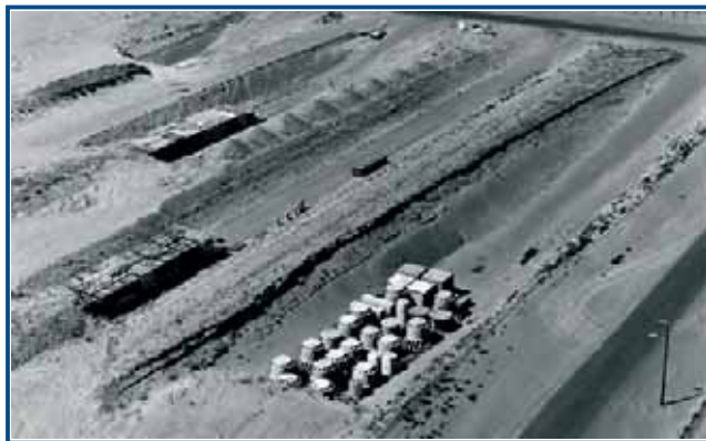
Рис. 1.29. Открытые траншеи пункта захоронения ТРО в Зоне 200 до закрытия слоем грунта
