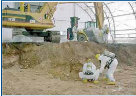
Рис. 1.133. Экскавация грунта под мобильными тентами
