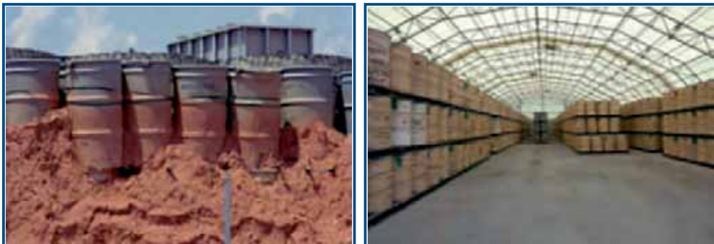
Рис. 1.58. Слева – бочки с ТРУ РАО до извлечения из траншеи, справа – после извлечения
