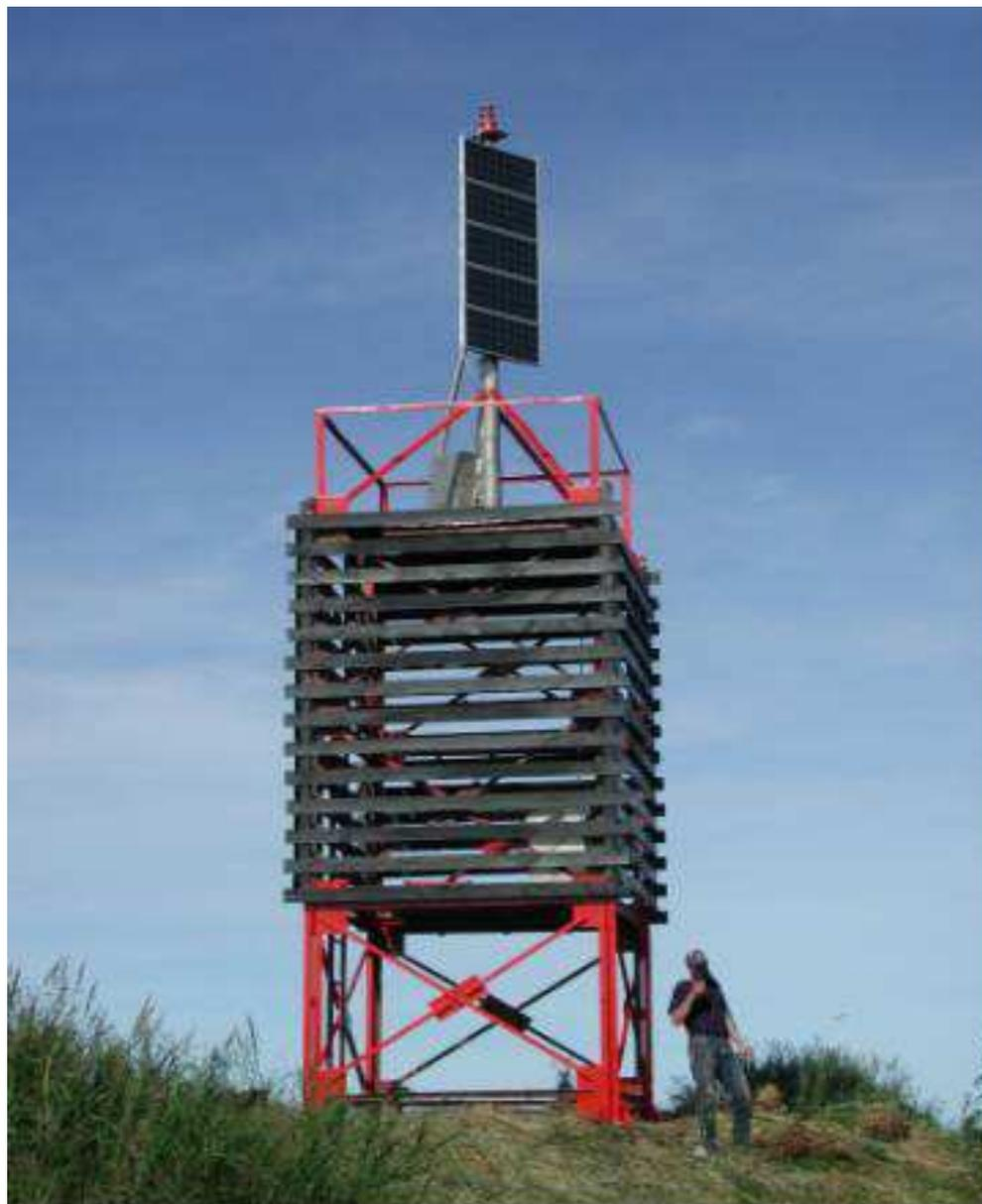
**Навигационный знак на Камчатке, на котором для замены РИТЭГа установлена фотоэлектрическая система**
