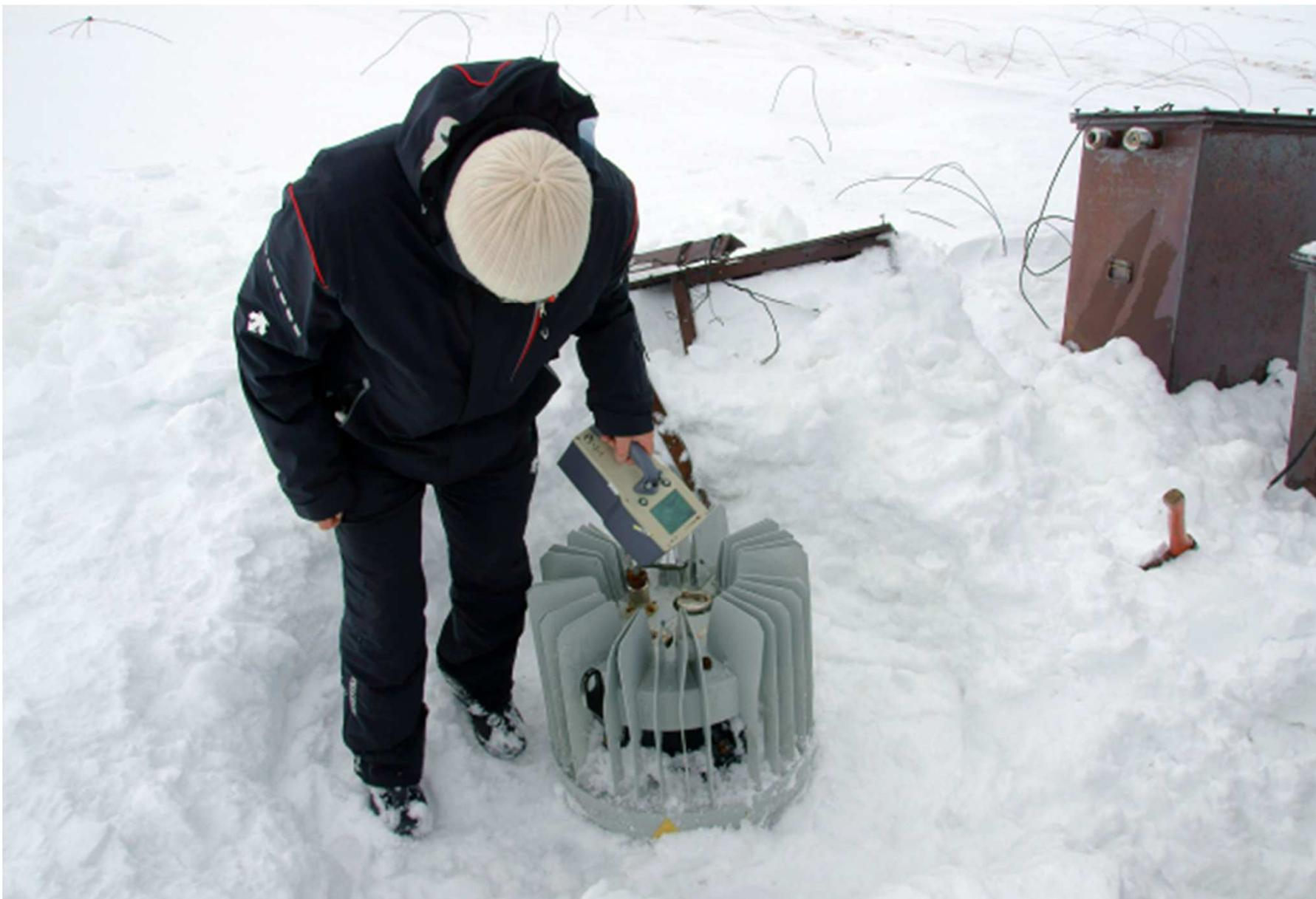
**РИТЭГ «Бета-М» в полевых условиях эксплуатации в Заполярье**
