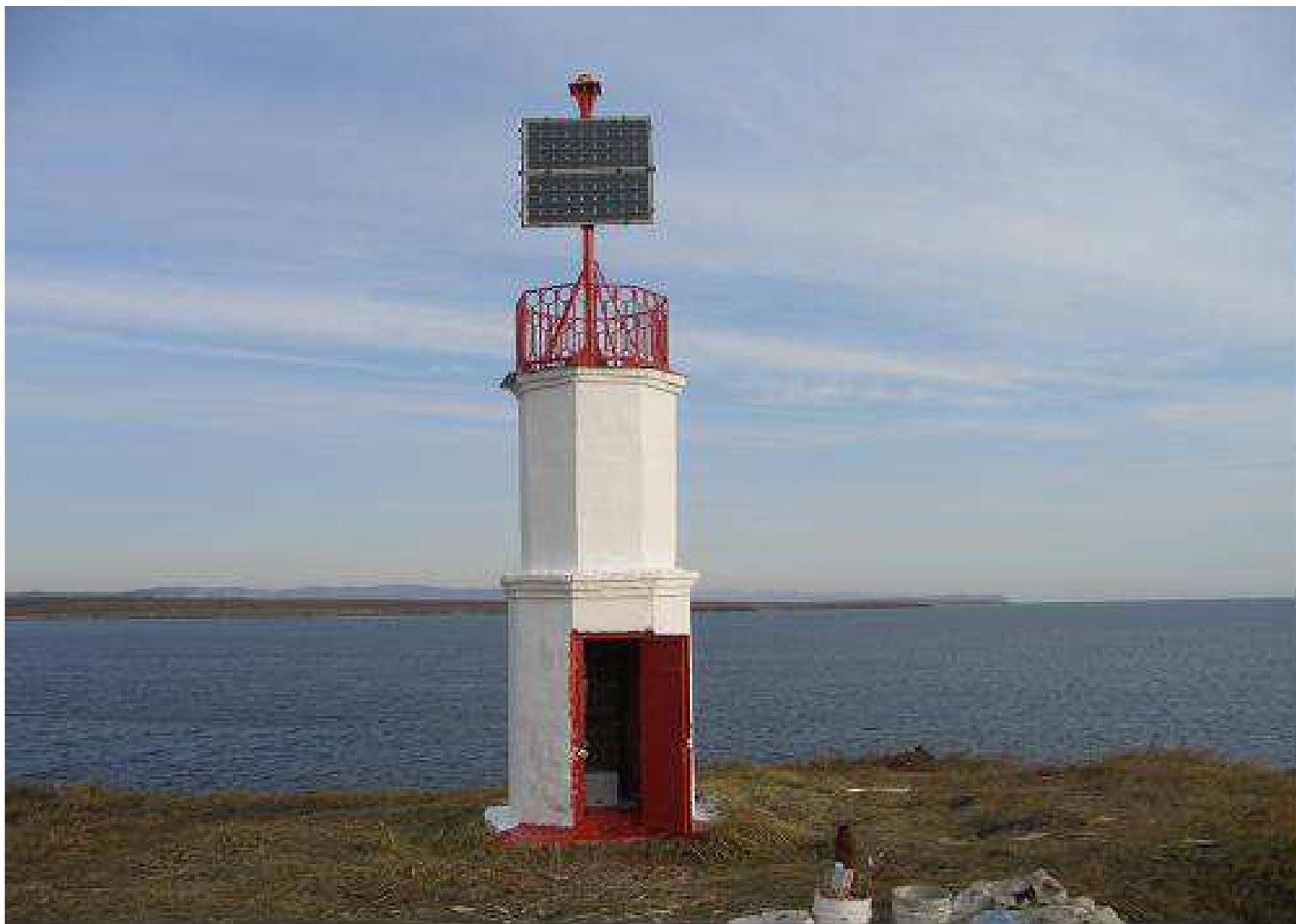
**Навигационный знак в Приморье, на котором для замены РИТЭГа установлена фотоэлектрическая система**
