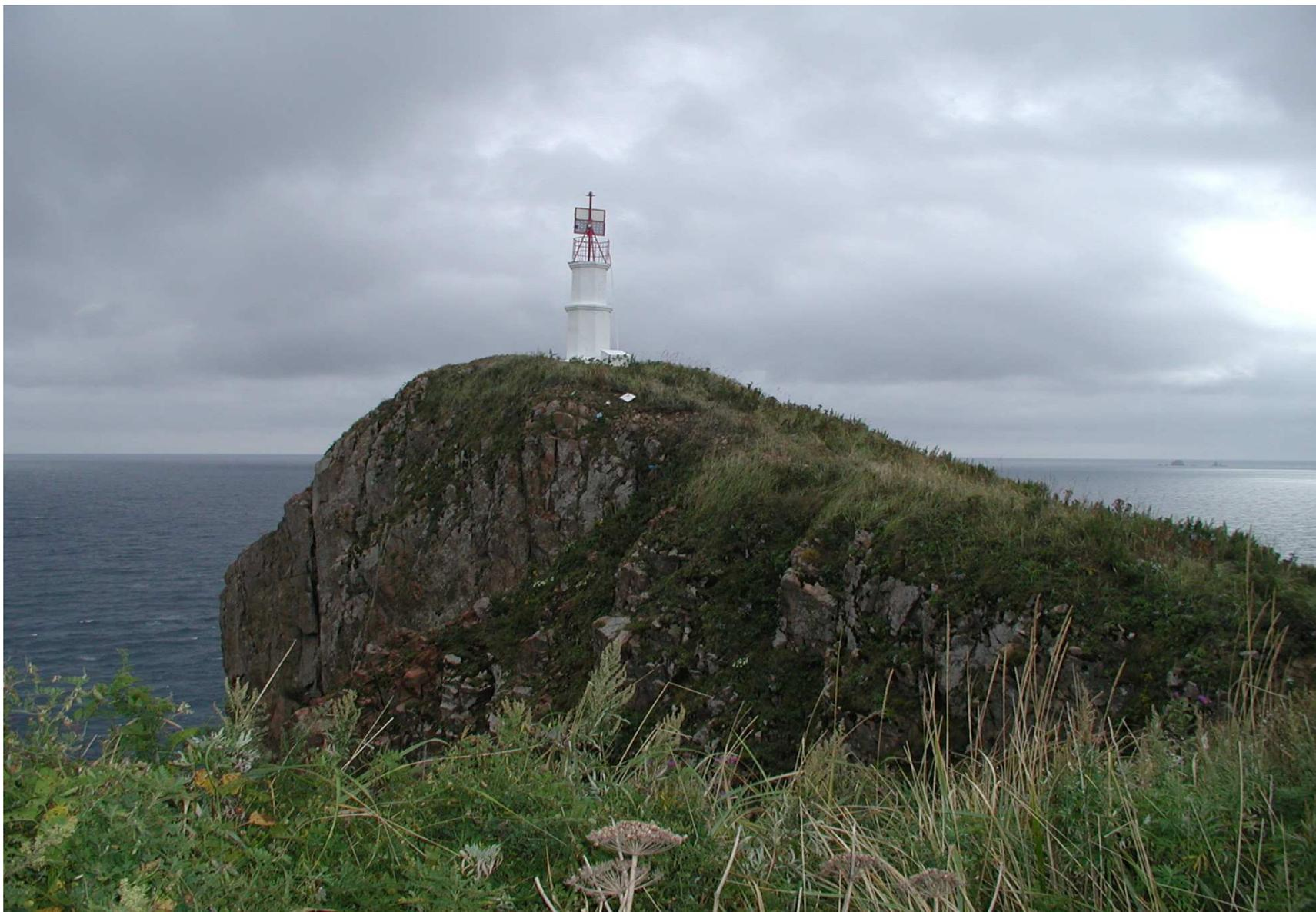
**Навигационный знак на мысе Шкота в Приморье, на котором для замены РИТЭГа установлена фотоэлектрическая система**
